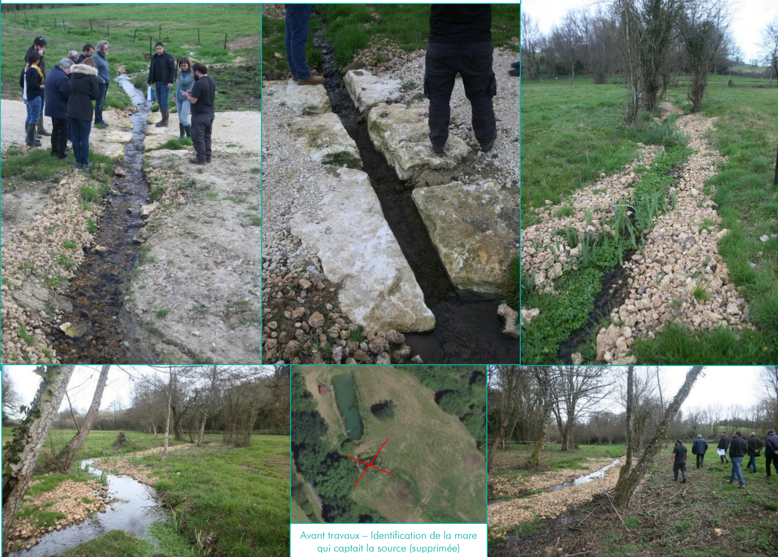
Passage à gué surplombant (compatible écrevisses) - pavé de blocs choisis en carrière enterré à 2/3
