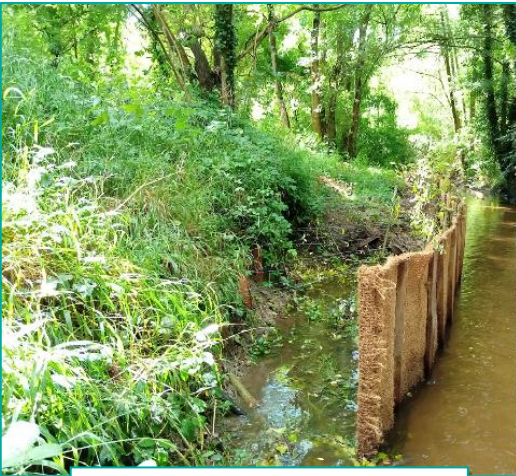
Installation en période de basses eaux
