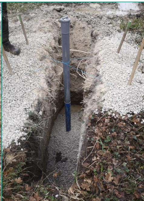
Installation du piézomètre
