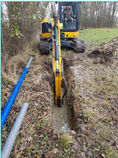
Creusement du trou à l'aide de la pelle mécanique
