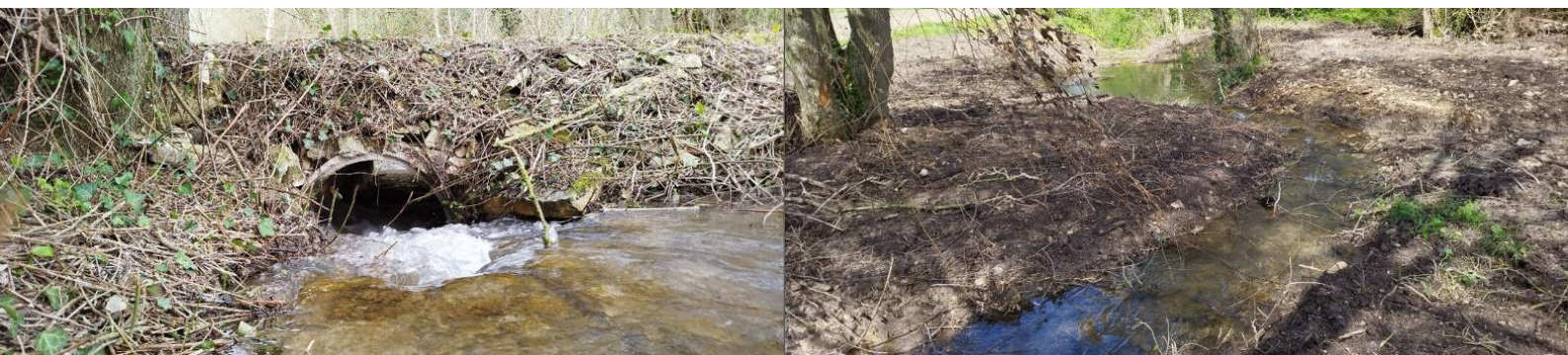
Enlèvement du passage busé, création d'un méandre
